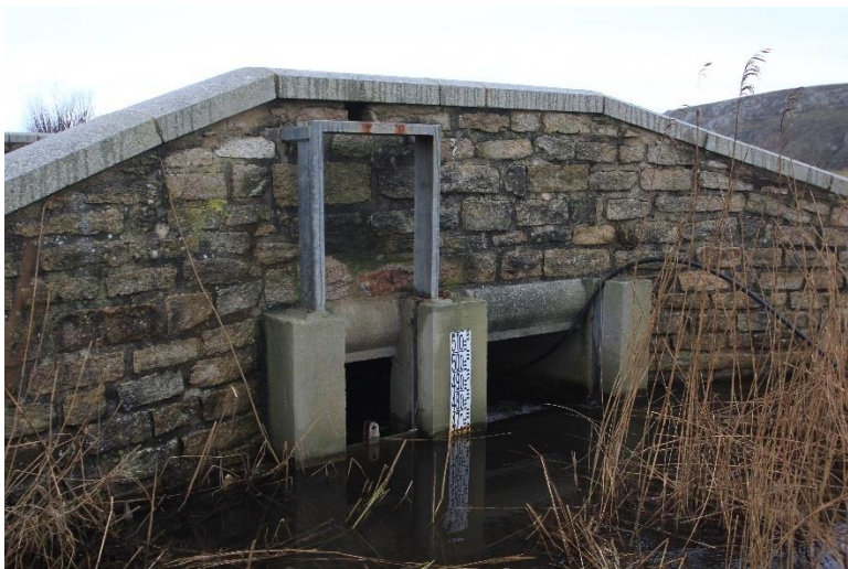
Photo 2 : Ouvrage hydraulique au niveau de la route départemental (photo : Erwan Stricot - CCCS-PR)
