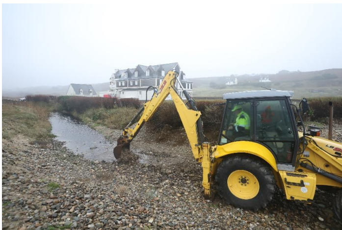
Photo 1 : Intervention de curage de l'exutoire en décembre 2021 (photo : Erwan Stricot - CCCS-PR)
